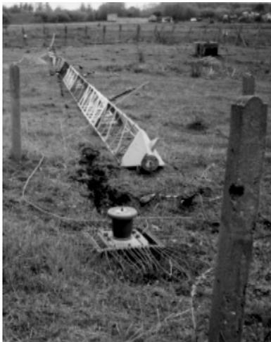
Der Gittermast stand auf einem isolierten Fuß (Topfisolator). Der Rest war nur noch Schrott und wurde von einer Entsorgungsfirma entsorgt.
