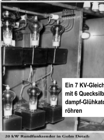
Ein 7 KV-Gleichrichter mit 6 Quecksilberdampf-Glühkathodenröhren
